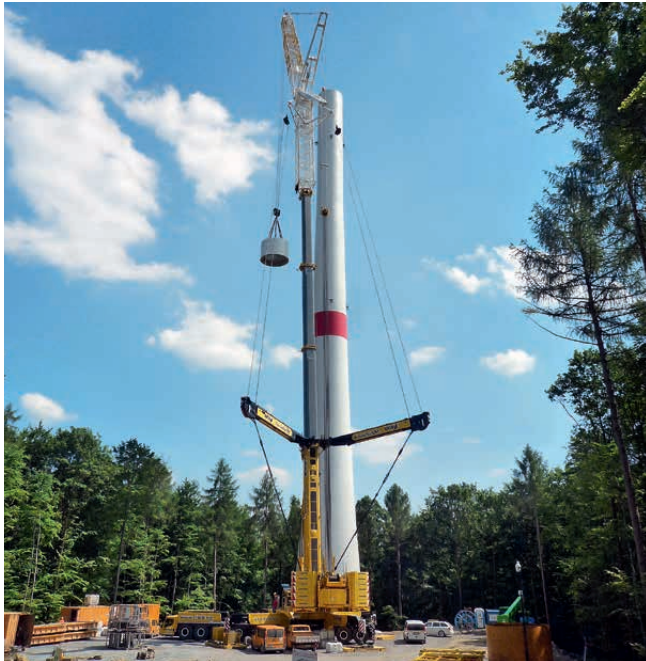
Der Windpark Ravenstein mit vier Windenergieanlagen im Neckar-Oldenwaldkreis in Baden-Württemberg ist im Bau und soll im 3. Quartal 2015 fertiggestellt werden.
