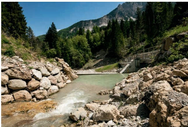
Wasserrfassung im Wasserkraftwerk Rite Basso.
