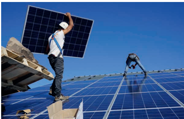
Anbringung der Solarparkfelder des Solarpark Mecobox.
