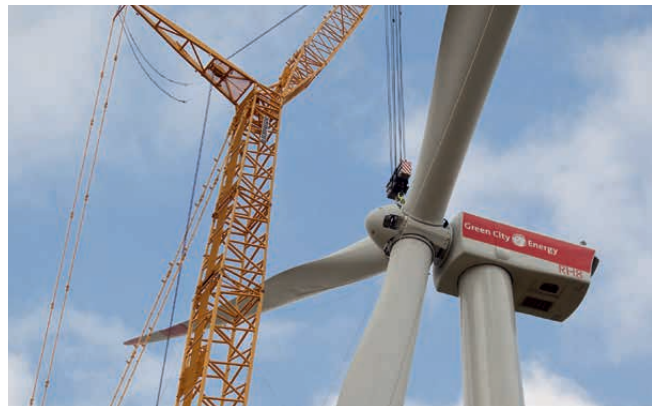
Fertigstellung des Windparks Sindorsdorf.
