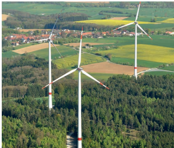
Der Windpark Bürgerwald ist seit Anfang 2017 in Betrieb.
