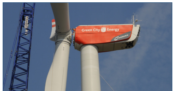
„Hochzeit“ von Gondel und Rotor an einer der Nordex-N117-Windenergieanlagen
