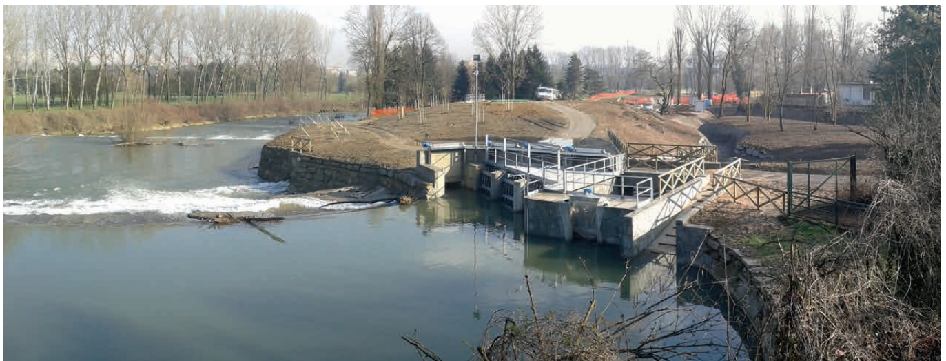
Das Wasserkraftwerk Pellerina wurde im gleichnamigen Stadtpark der norditalienischen Metropole Turin errichtet. Zukünftig soll das überwiegend unterirdische Kraftwerk mit 600 kW Konzessionsleistung rund 2,4 Mio. Kilowattstunden Ökostrom produzieren.
