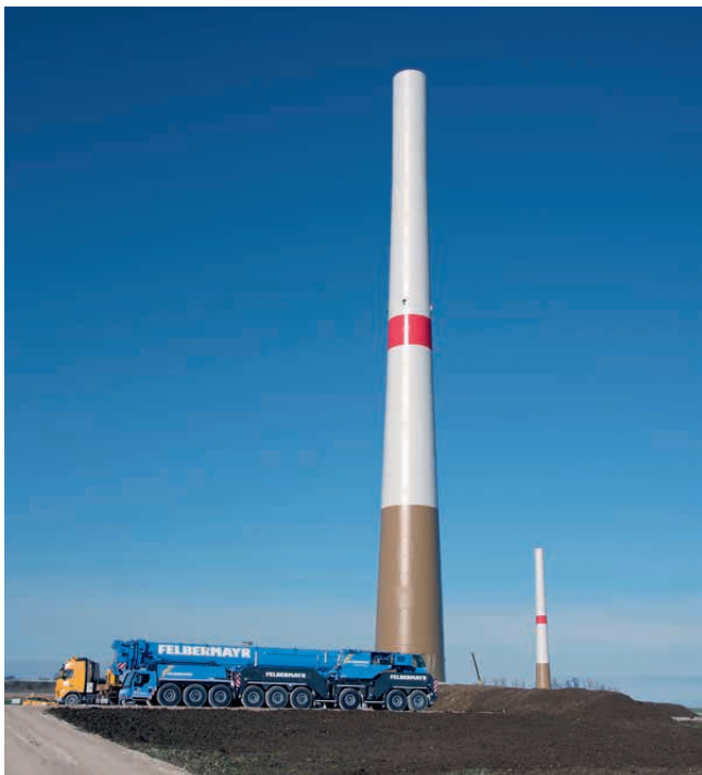
Die Türme des Windparks Sindorsdorf wurden bereits aufgestellt.
