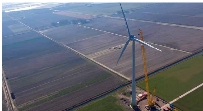
Montage einer Enercon-Windkraftanlage
