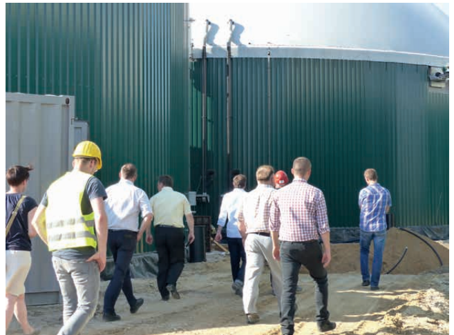
Besichtigung der Biogasanlage Thierbach.
